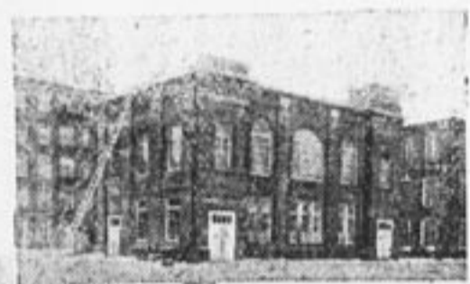
Здание вновь построенной передаточной электро-станции при крупной фабрике «Коммунистический Авангард» во Владимирской губ.
